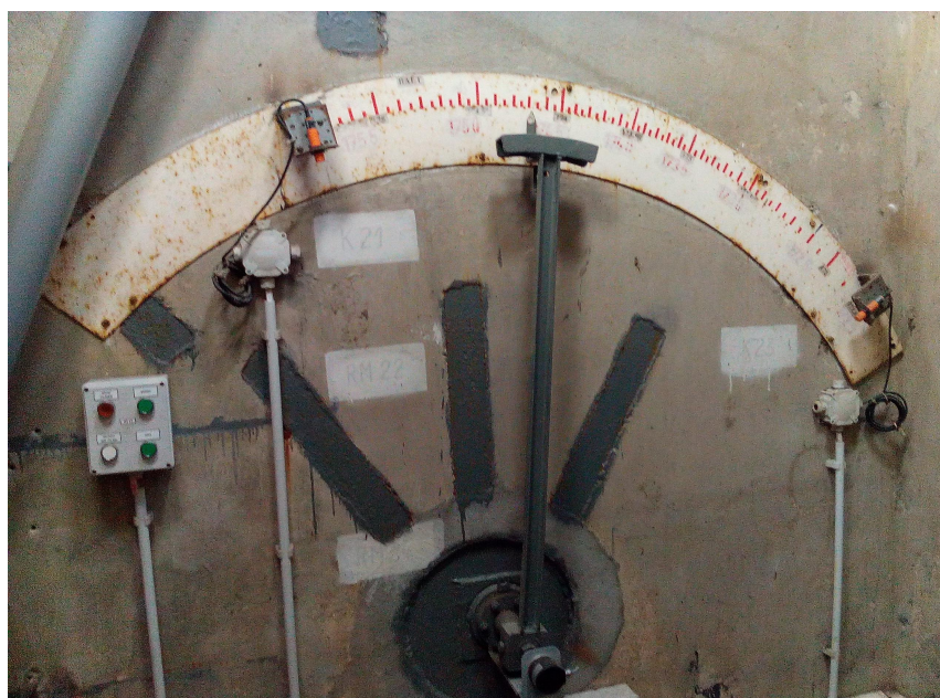
Foto č. 9 – Zařízení na snímání polohy klapky
