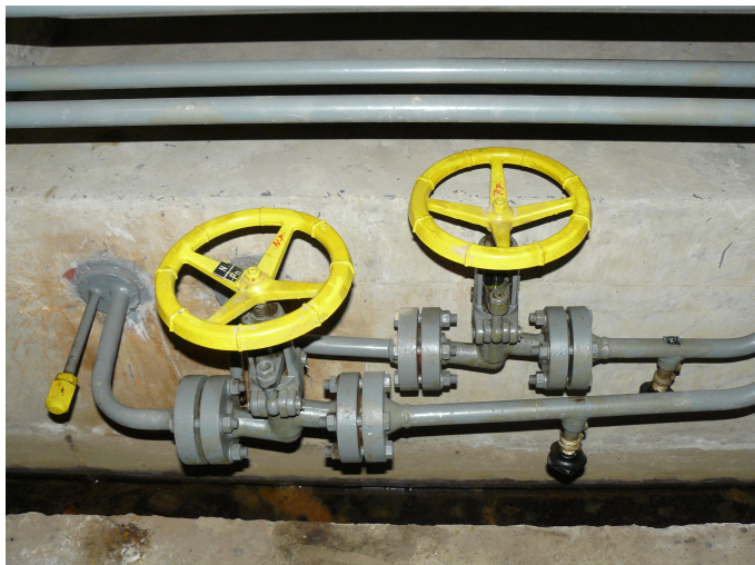
Foto č. 10 – Stávající uzavírací ventily na hydraulickém rozvodu
