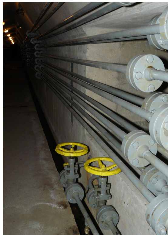
Foto č. 6 – Uzavírací armatury hydraulického rozvodu
