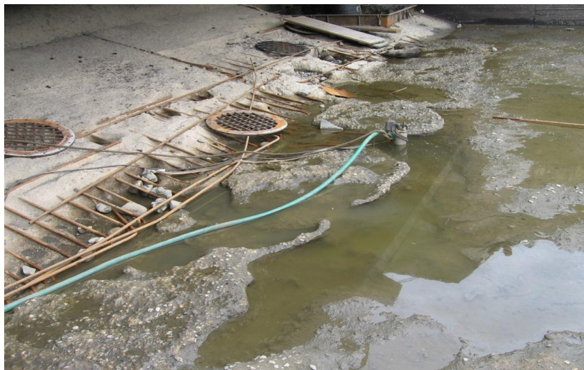
Foto č. 12 – Předpokládaný rozsah poškození vývaru klapky (ilustrační foto)
