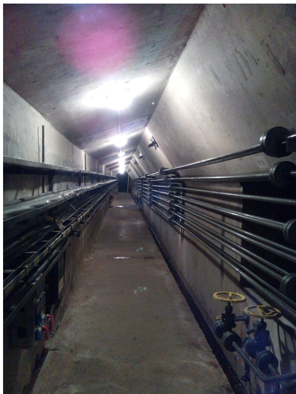
Foto č. 5 – Pohled do jezové štoly s hydraulickými rozvody
